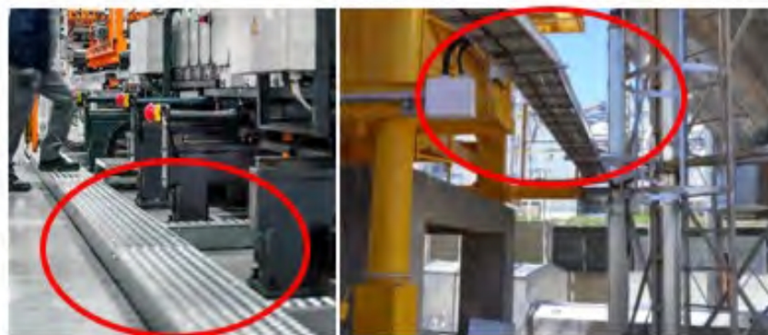
Figura 3. 17 Opciones de cableado para el sistema Izquierda: Cableado por suelo. Derecha: Cableado por aire o techo. Fuente: Elaboración Propia
