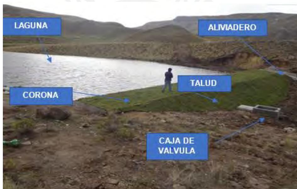
*Figura 10. Elementos de dique construido
