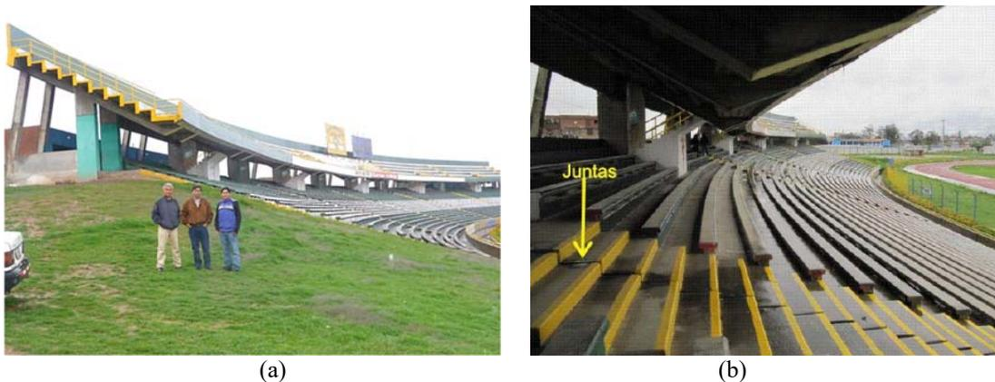
Figura 1. Tribuna Oriente del Estadio Huancayo: (a) relleno superficial de 2.00 metros de altura y (b) junta de separación abierta en la gradería del primer nivel.
