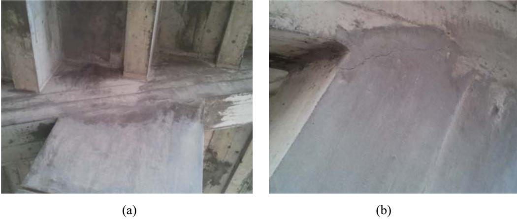
Figura 27. Fisuras en los nudos viga-columna: (a) pórticos exteriores y (b) pórticos interiores.
