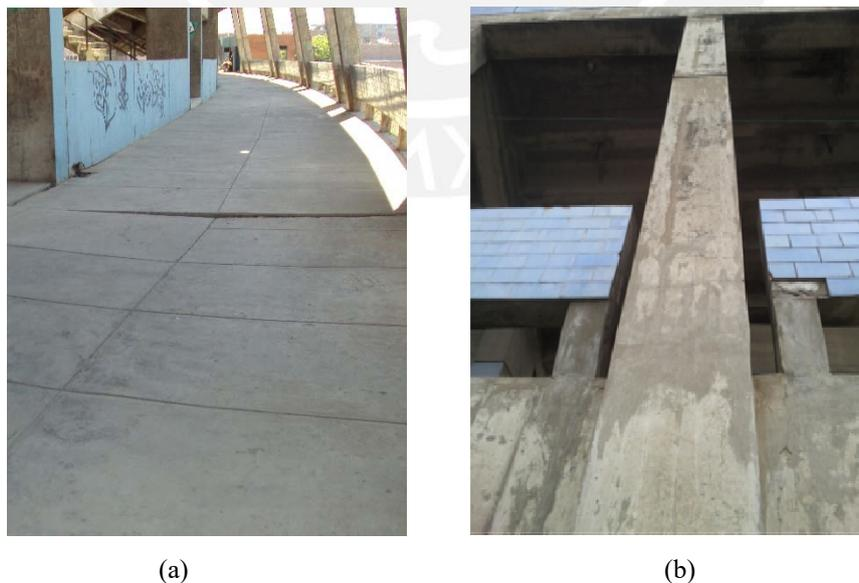
*Figura 2.* Anomalías en las estructuras de la tribuna Oriente del estadio Huancayo: (a) hundimiento en pisos y (b) fisuras horizontales en columnas.
