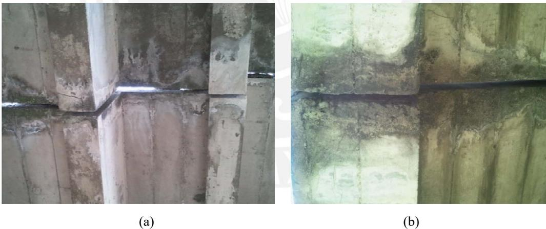
Figura 28. Humedad en las graderías del segundo nivel: (a) desprendimiento del concreto de viguetas y (b) deterioro del concreto debido a la humedad.
