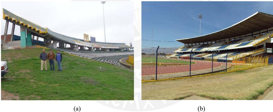
Figura 23. Tribunas del estadio Huancayo: (a) tribuna Oriente con presencia de fisuras e inestabilidad y (b) tribuna Occidente en buen estado de conservación.
