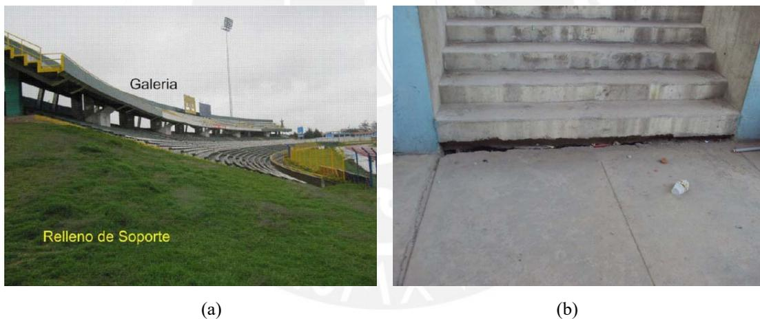
Figura 26. Asentamiento diferencial: (a) tribuna Oriente construida sobre un relleno y (b) asentamiento diferencial del piso debido a procesos de debilitamiento del relleno sobre el cual se construyó la tribuna.
