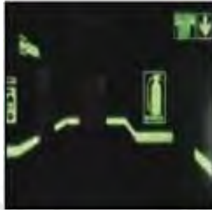
Figura 6. Ejemplo de iluminación fotoluminiscente
