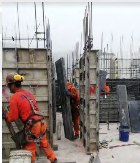
Figura 21. Encofrado monolítico.
