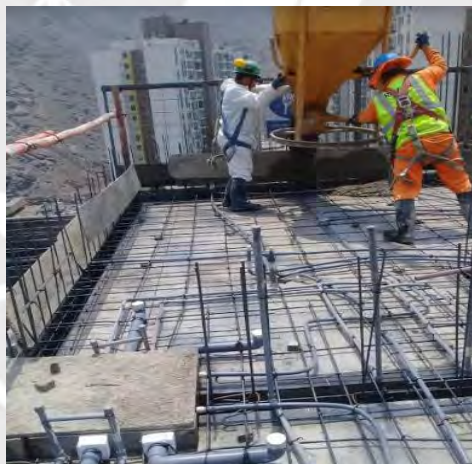
Figura 18. Vaciado monolítico.
