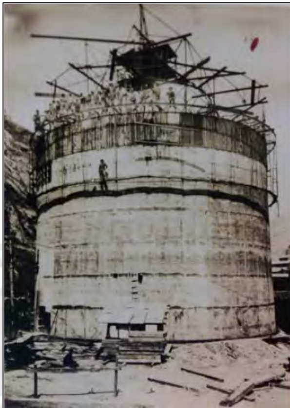
Figura 10: Chimenea Cottrell durante su construcción Fuente: Sifuentes, 2017:120.
