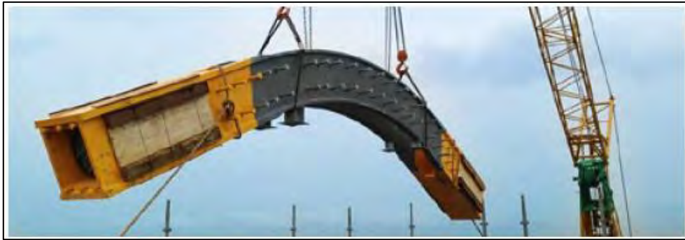
Figura 3.4-15: Erección de anclaje con cajuela metálica de la marca DSI (DSI, 2016)
