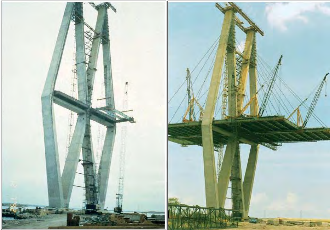
Figura 4.4.1-3: Instalación de los segmentos de vigas metálicas del Puente Baytown (Svensson, 2012)
