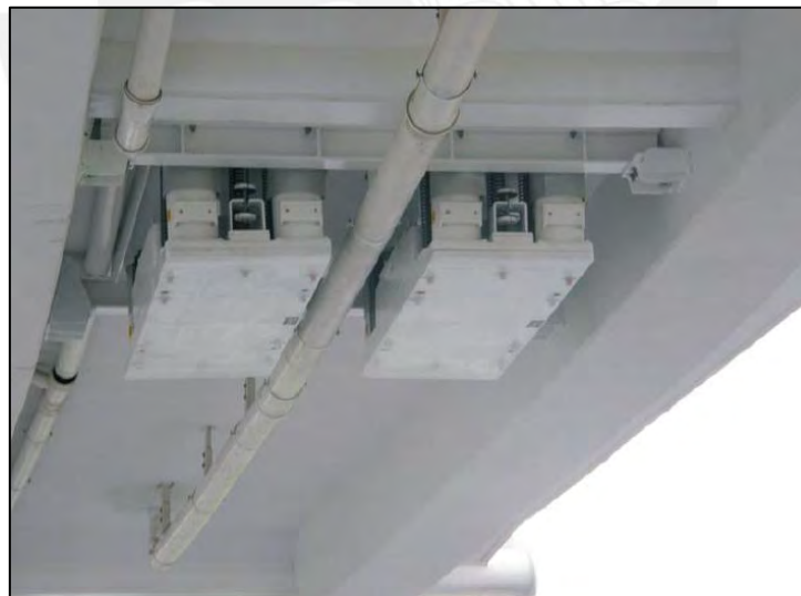
Figura 5.2.8-2: Amortiguadores de masa sintonizada en el puente atirantado peatonal Malta Center (Fiebig, 2010).
