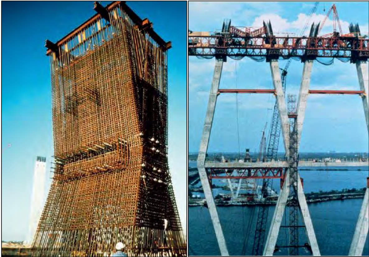
Figura 4.4.1-2: Construcción de las torres del Puente Baytown (Svensson, 2012)
