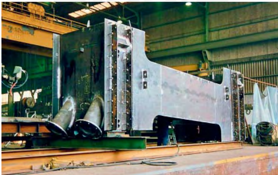
Figura 3.4-12: Construcción del anclaje compuesto con cajuela metálica, Puente de Normandía (Svensson, 2012)
