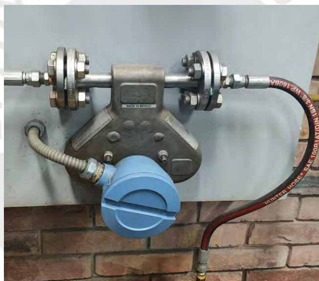
Figura 20 - Medidor de Flujo de combustible tipo coriolis
