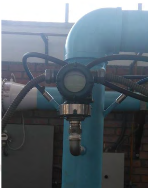
Figura 24 - Sensor de presión de bajas presiones
