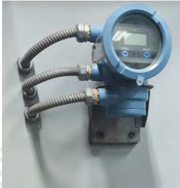
Figura 21 - Transmisor de flujo de combustible
