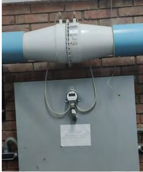
Figura 23 - Sensor de presión diferencial y medidor de flujo tipo laminar.
