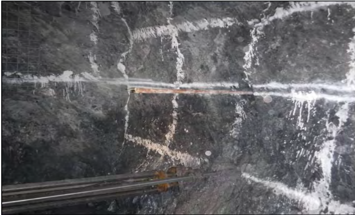
Figura 27. Foto de una perforación de taladros en una excavación subterránea. Tomado de Revisiones Gerenciales de Reliant , por J. Huamaní, 2019, Kitwe, Zambia: Reliant.
