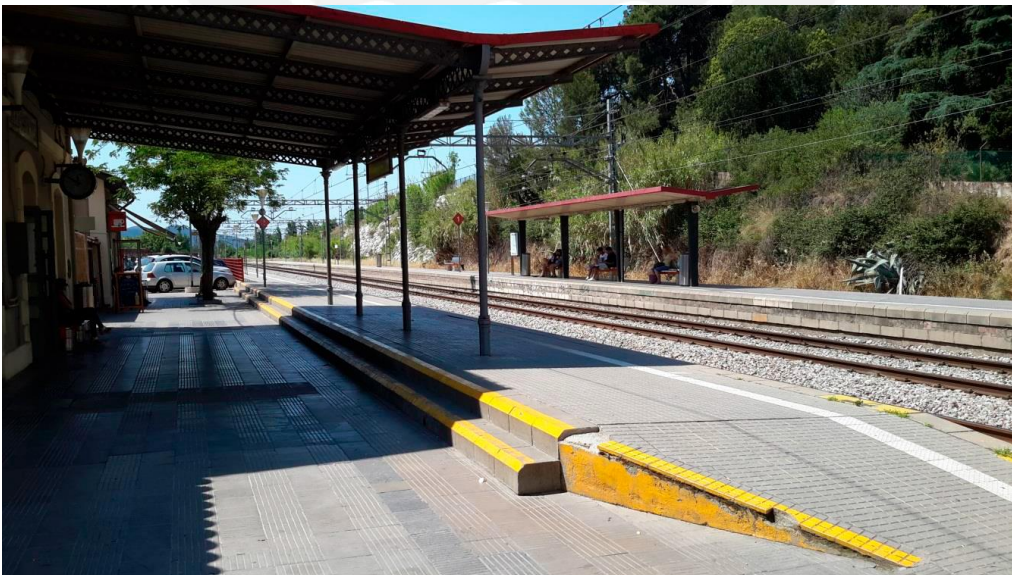
Figura 1.6. Rampa y escalones que salvan la diferencia de cota del andén principal.
