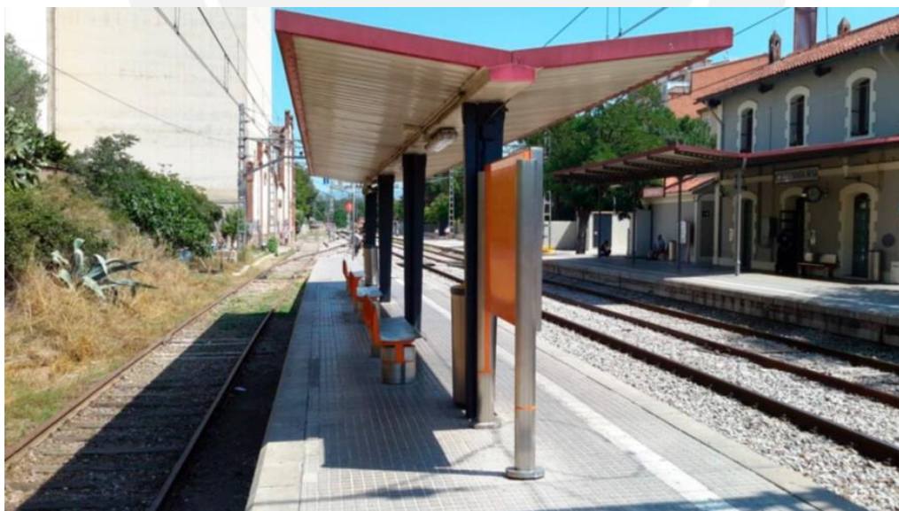
Figura. 1.7. Marquesina situada en el andén central.
