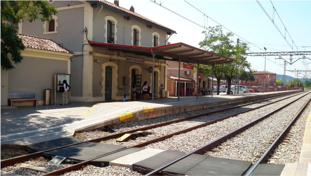
Figura.1.5. Paso strail que conecta ambos andenes.
