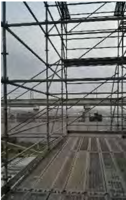
Fotografía 5.7.- Plataforma de andamios debidamente instalada y lista para su uso
