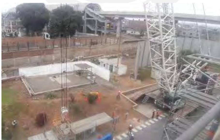
Fotografía 5.11.- Maniobras de izaje con grúa principal durante el proceso de reemplazo de silenciadores
