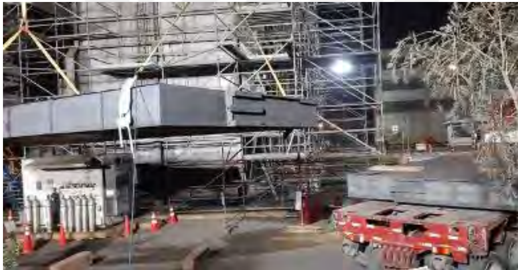
Fotografía 5.14.- Izaje de un silenciador de la chimenea, final de la maniobra
