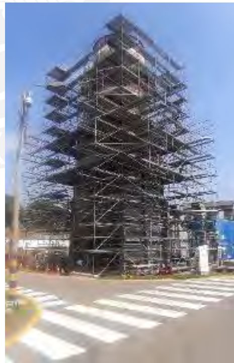
Fotografía 5.4.- Unidad de generación TG8, montaje de andamios al 100%
