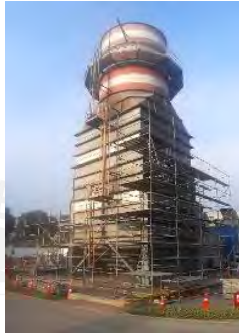
Fotografía 5.2.- Unidad de generación TG8, continuación del montaje de andamios alrededor de la chimenea
