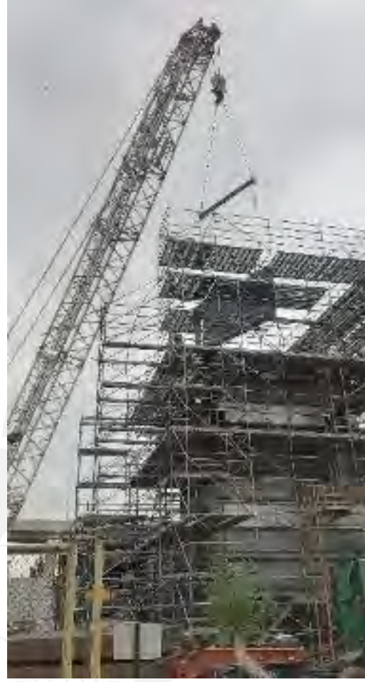
Fotografía 5.13.- Izaje de un silenciador de la chimenea, inicio de la maniobra
