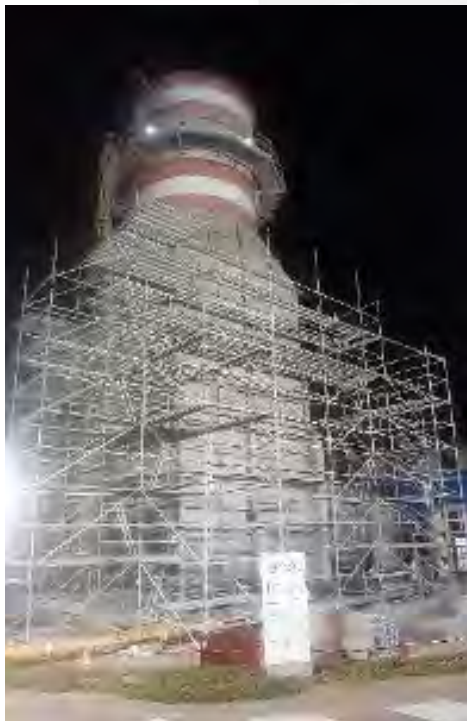
Fotografía 5.3.- Unidad de generación TG8, montaje de andamios al 50%
