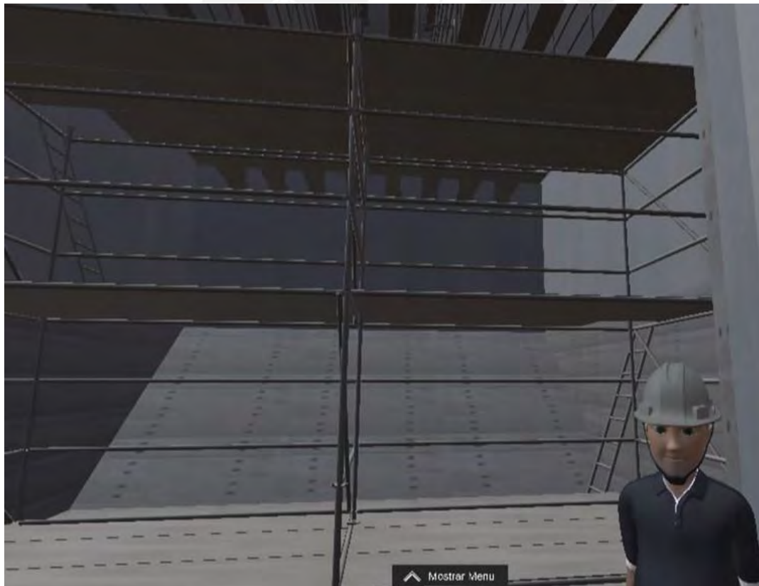
Figura 4.14.- Sesión de aprendizaje de actividad 2, montaje de andamios internos
