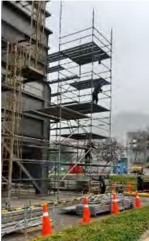
Fotografía 5.5.- Colaboradores durante el proceso de montaje de andamios
