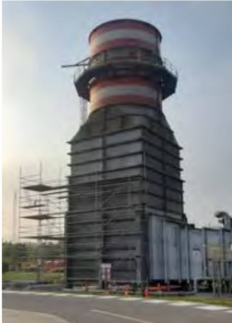
Fotografía 5.1.- Unidad de generación TG8, inicio del montaje de andamios alrededor de la chimenea
