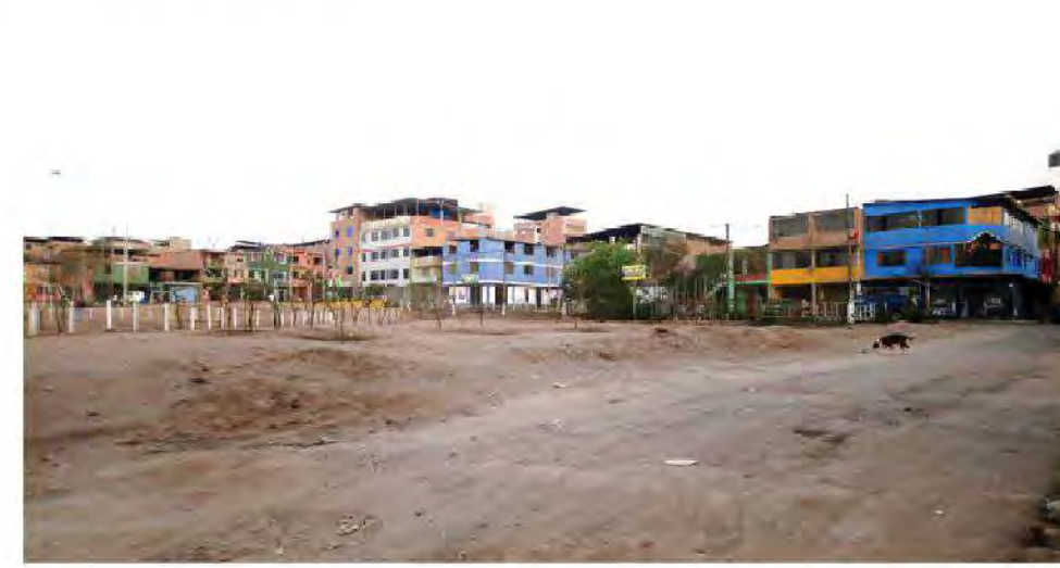
Vereas destruidas o inexistentes
