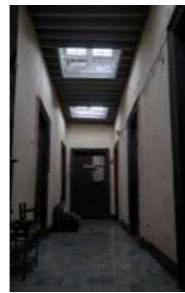
Pasillo a cuartos
