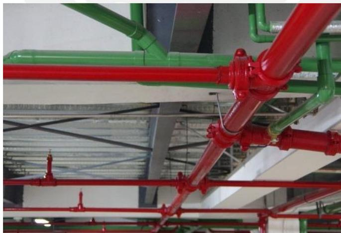
*Figura 8.* Red de tubería de agua contra incendios.
