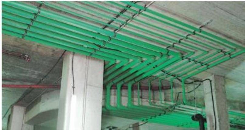
*Figura 6.* Tubería de polipropileno
