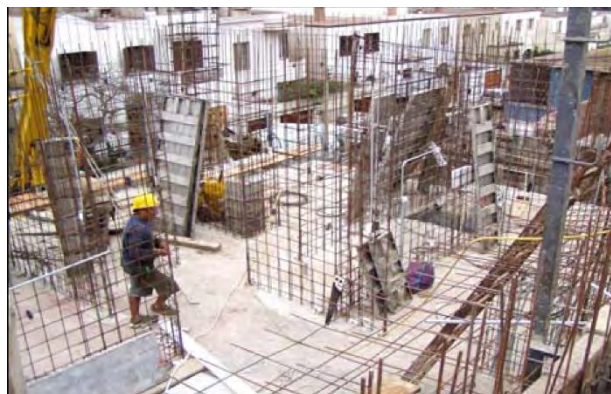
Figura 2.1: Construcción de un edificio de muros de ductilidad limitada. Fotografía gracias al Dr. Alejandro Muñoz.
