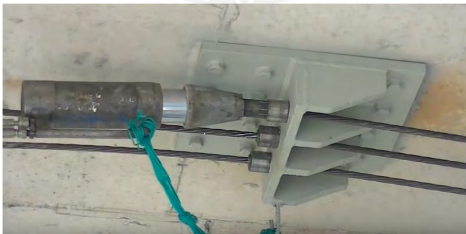
Figura 2. 34 Tensado de cables de acero para postensado de losa.
