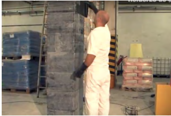
Figura 2. 29 Colocación de la segunda capa de resina epóxica sobre nuevo sistema CFRP en columna. Nota: Tomado del canal de Youtube: Sika España (4m00s), 2011.
