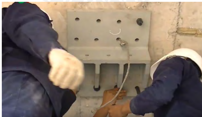
Figura 2. 32 Colocación de plancha metálica de anclaje para postensado de losa.
