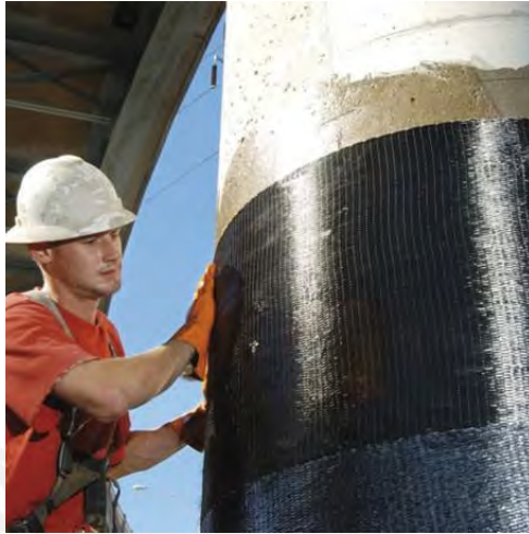
Figura 2. 23 Fibra de carbono en pilar de columna de concreto armado con SikaWrap-600C°. Nota: Recuperado de Sika (2017): Imagen de la colocación de Fibra de Carbono en el pilar de columna.
