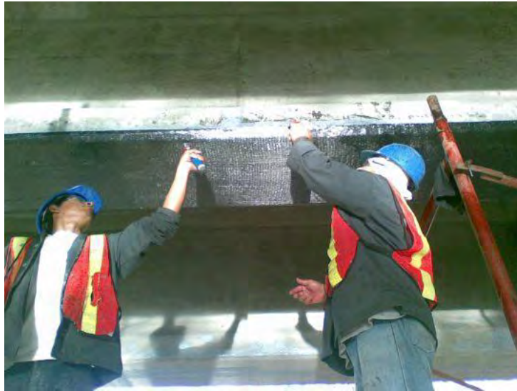
Figura 2. 21 Fibra de carbono en viga de concreto armado. Nota: Recuperado de Puente Empalme Lovago-Nicaragua, 2011.
