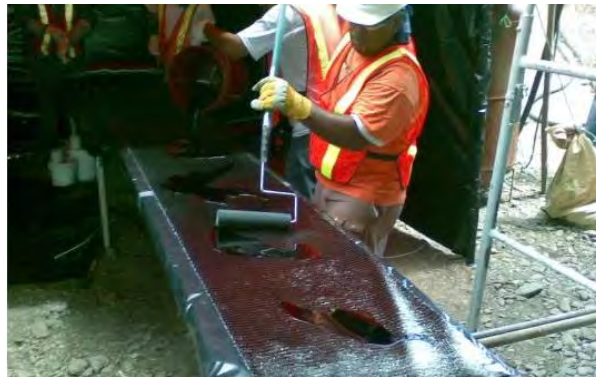
Figura 2. 27 Aplicación de la resina epóxica sobre la tela de fibra de carbono. Nota: Recuperado de empalme Pájaro Negro (2012). Nicaragua.
