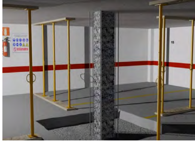
Figura 2. 14 Colocación de los nuevos refuerzos longitudinales y estribos.
