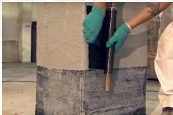
Figura 2. 28 Colocación de la fibra de carbono sobre la superficie de una columna de concreto a reforzar. Nota: Tomado del canal de Youtube: Sika España (3m43s), 2011.
