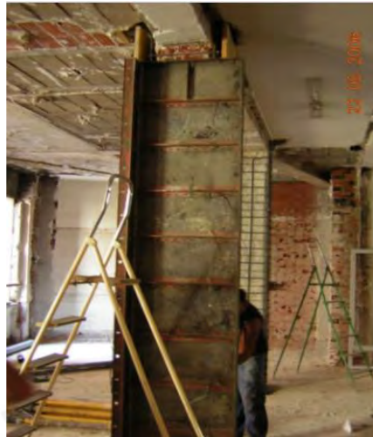
Figura 2. 16 Encofrado del refuerzo.
