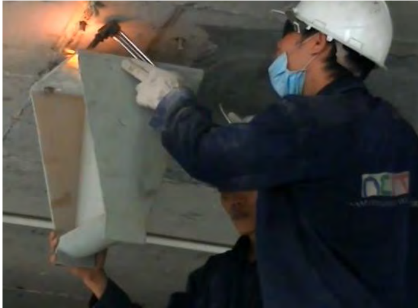
Figura 2. 33 Colocación de sistema de soporte para postensado de losa.
