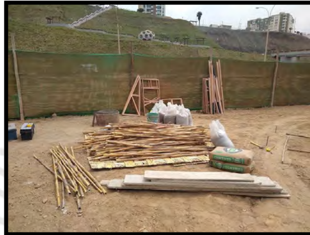
Figura 28: Designación de lugares en obra. (Fuente propia)
