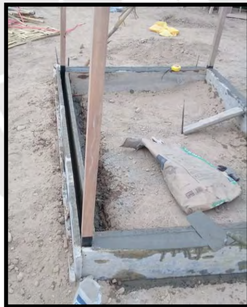
Figura 34: Vaciado de concreto. (Fuente propia)
