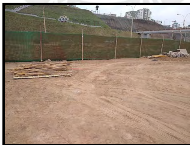
Figura 29: Nivelación de terreno. (Fuente propia)
