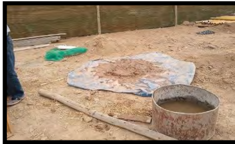
Figura 38: Preparación de la mezcla de barro. (Fuente propia)
