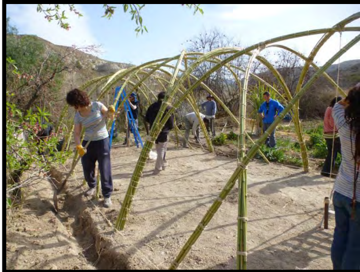
Figura 69: Procedo de armado de la estructura de caña para un invernadero ecológico (Fuente: ecoinventos, 2015)
