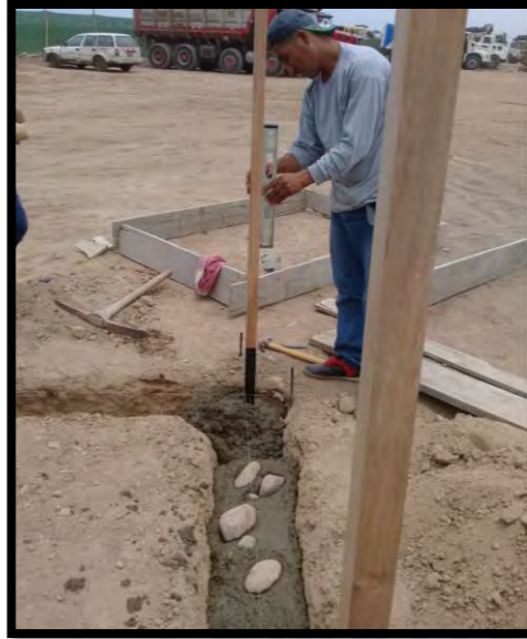
Figura 33: Vaciado de concreto y colocación de columnas. (Fuente Propio)
