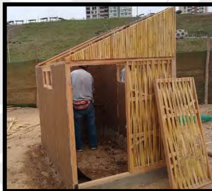
Figura 39. Vaciado de la mezcla en la estructura. (Fuente propia)
