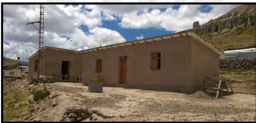
Figura 5: Vivienda construida con sistema de Transferencia tecnológica (Fuente: CIAC – Centro Tierra, 2016)
