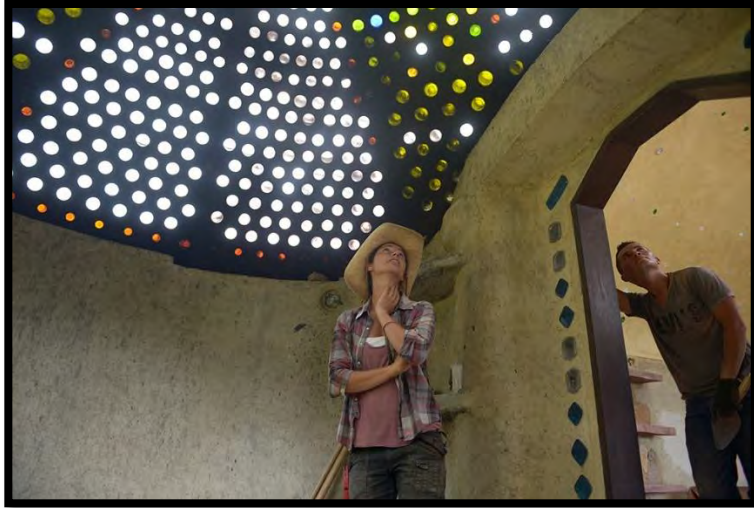
Figura 75: Construcción de casas con materiales reciclables en Colombia (Fuente: Posada, 2015).
