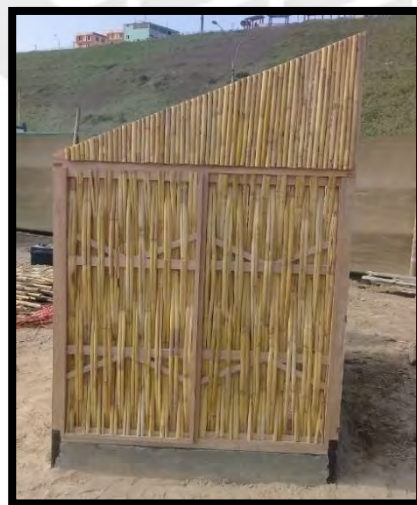
Figura 37-C: Vista 3 de colocación de paneles y tijerales. (Fuente propia)
