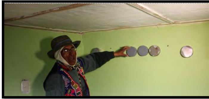
Figura 6 - C: Techo aislado del sistema K'ONICHUYAWASI (Fuente: Grupo PUCP, 2016).
