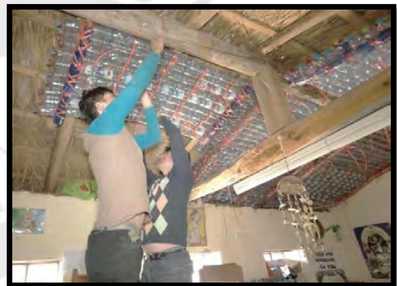
Figura 2-B: Colocación de parrillas en techo de vivienda. (Fuente: Moncloa, C., 2017)
