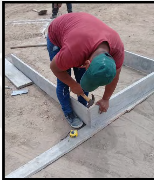
Figura 32. Colocación de madera. (Fuente propia)
