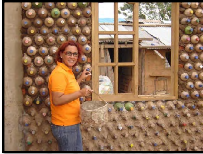
Figura 72: Construcción de una vivienda del programa “Casas de botella” en Bolivia. (Fuente: Vaca, 2017)
