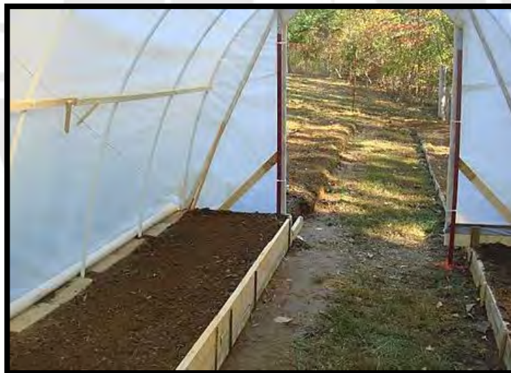
Figura 70: Acabado final de un invernadero ecológico a base de cañas (Fuente: ecoinventos, 2015)
