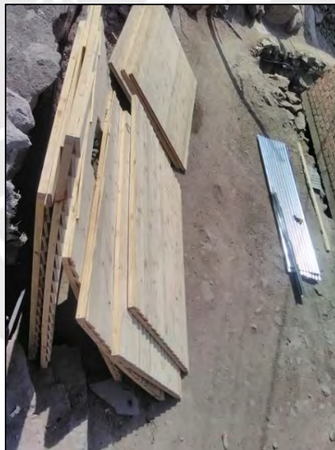
Figura 17 Posición final de los paneles
