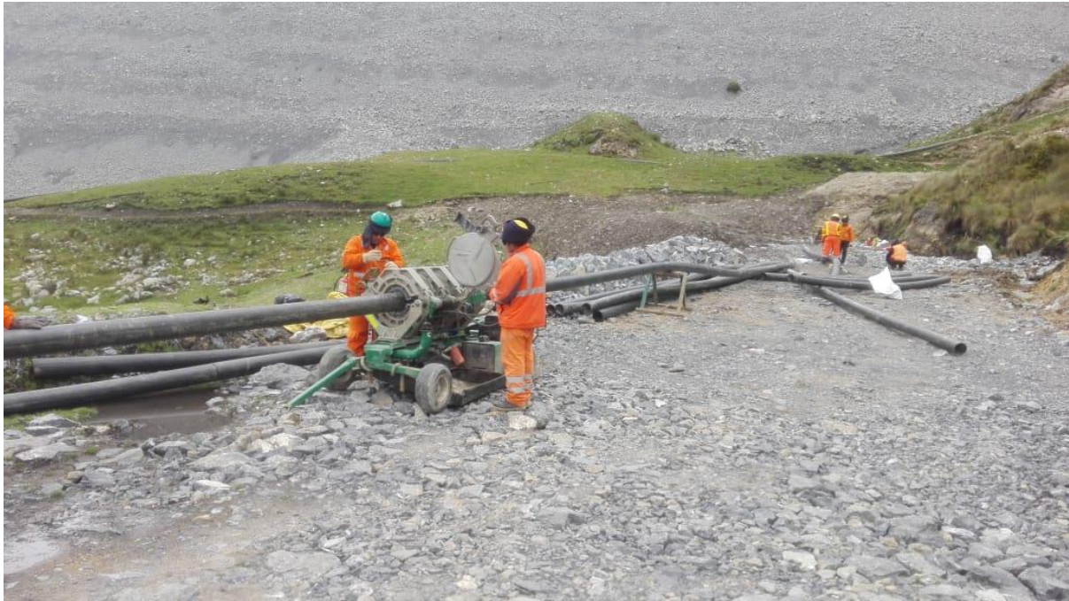
Figura 3. Instalación de tuberías HDPE. Sistema de aguas de recirculación del drenaje de la presa de relaves. Cliente: Gold Fields La Cima.
