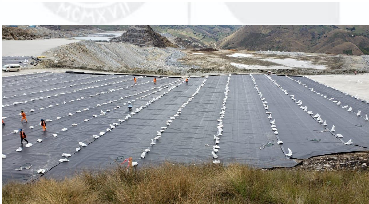
Figura 2. Instalación de geomembrana. Impermeabilización del depósito de desmante Facilidades. Cliente: Gold Fields La Cima.
