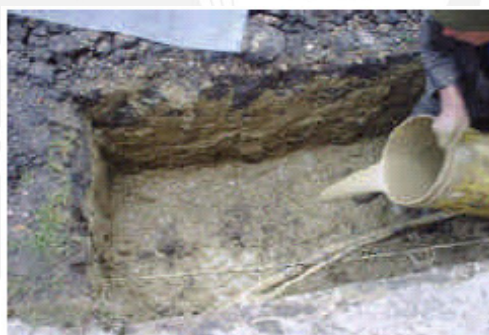
Figura 4.16 Instalación del sistema de puesta a tierra
