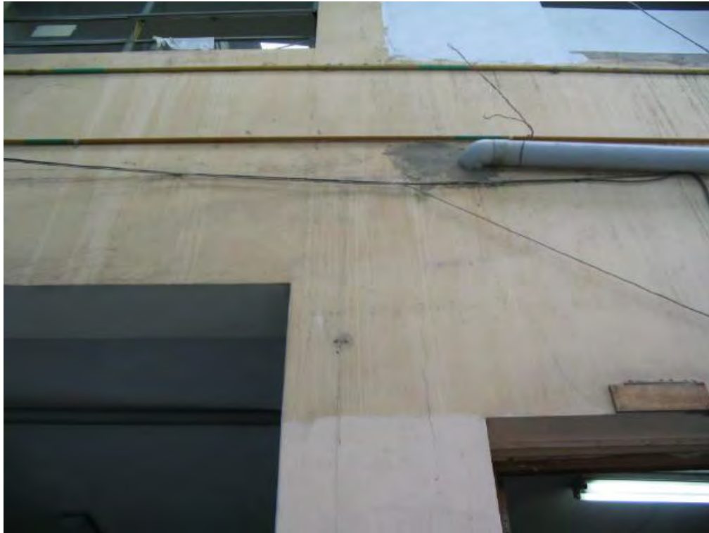
Tendido del cable hacia el departamento de cirugía.
