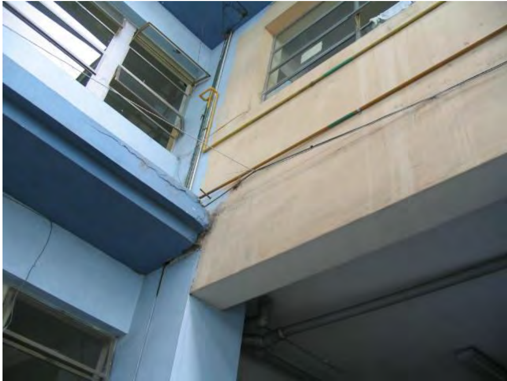
Descripción de la forma como fue tendido el cable UTP hacia departamento de Patrimonio
