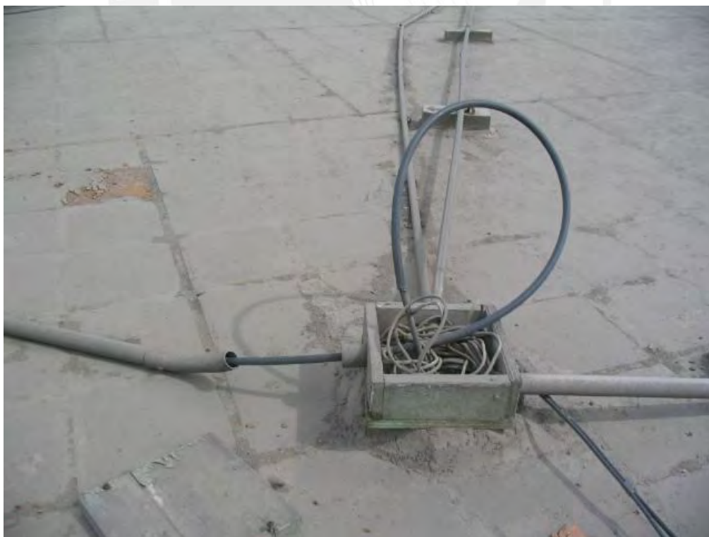
Llegada de la FO. al departamento de Servicio Social y distribución de cable UTP
