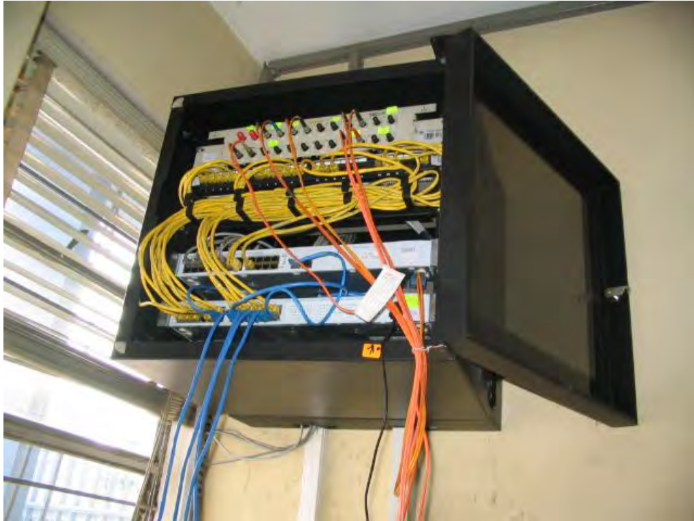
Gabinete del backbone en el departamento de informática
