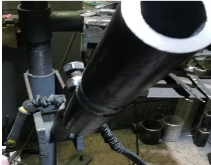
Figura 2.15 Alineamiento de cupón de soldadura
