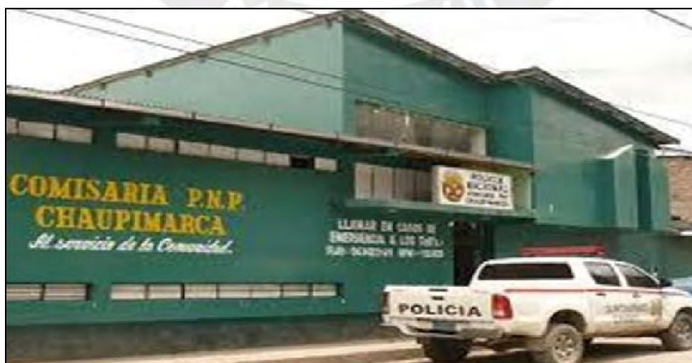
Figura 5. Comisaría de Chaupimarca – Pasco Fuente: Municipalidad Distrital de Chaupimarca (2019)
