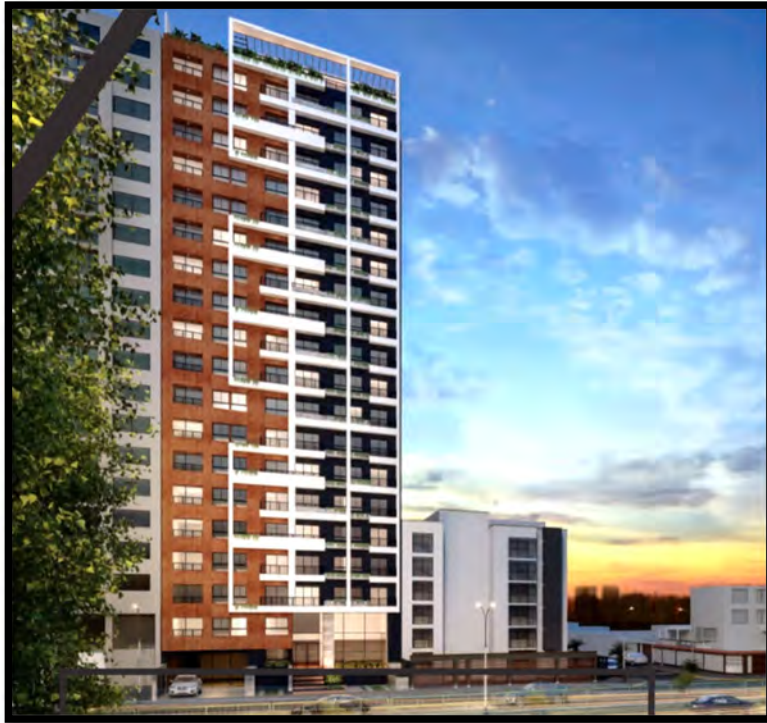
Figura 25 – Vista Frontal Proyecto Switch
