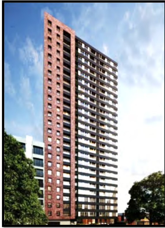
Figura 22 – Vista Frontal Proyecto Alter 25
