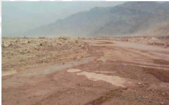
Pérdida de fracción gruesa
