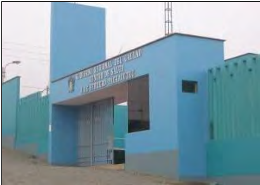
Fotografía N° 4: Centro de Salud “3 de Febrero”
