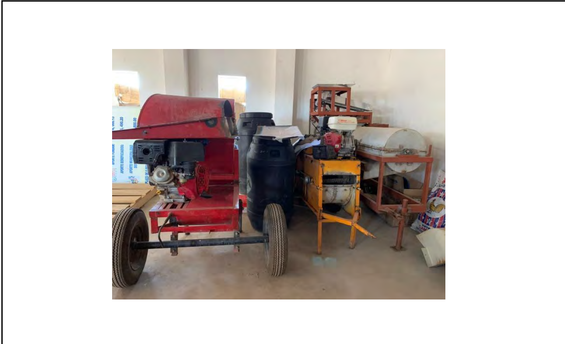
Figura B5: Maquinaria del Centro de Servicios
