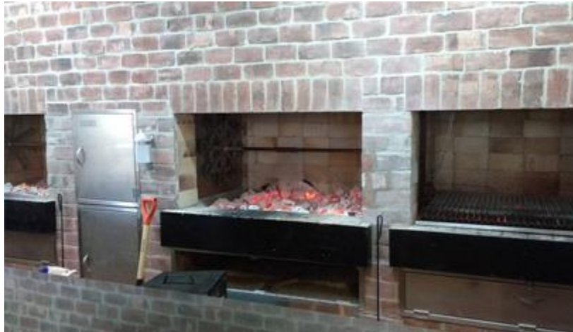
Figura 2.16 Horno de ladrillos refractarios. Fuente: [36]
