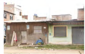
4. Viviendas precarias cerca al río
