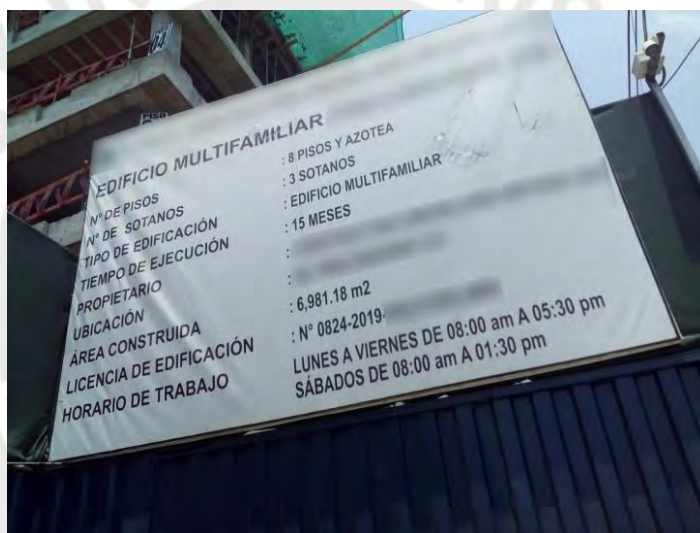
Figura 6.2 Verificación de la existencia del cartel de obra
