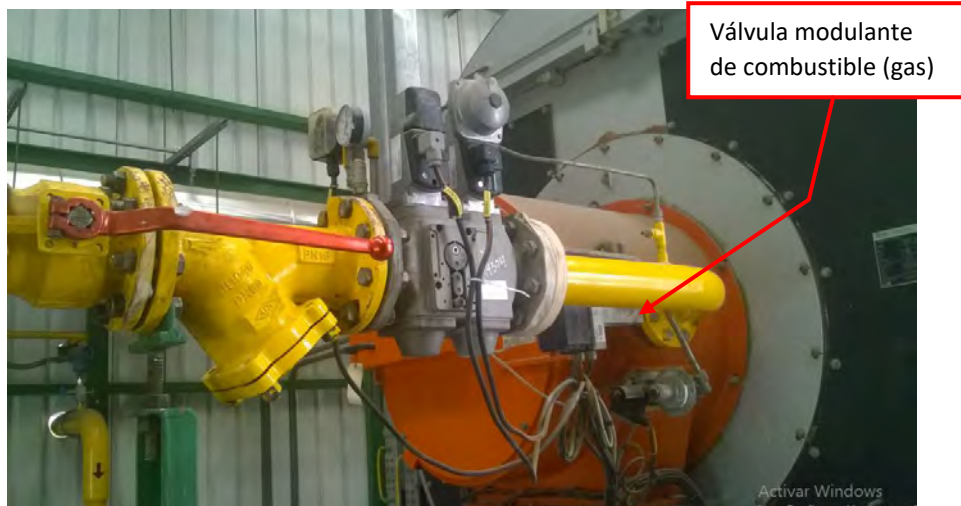
Figura 2.27. Imagen del quemador de la caldera objeto de estudio.
