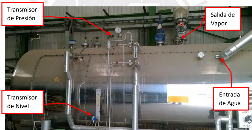
Figura 2.28. Imagen lateral de la caldera objeto de estudio.
