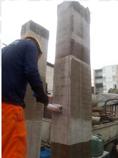
Figura 4.12. Colocación de resina epóxica. (Fuente: Propia)
