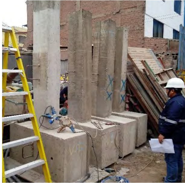
Figura 4.9. Preparación de superficies a reforzar. (Fuente: Propia)
