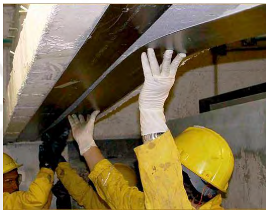
Figura 2.3 Viga de concreto armado reforzada con sistema CFRP, ejecutado por Top Consult Ingeniería (2016)
