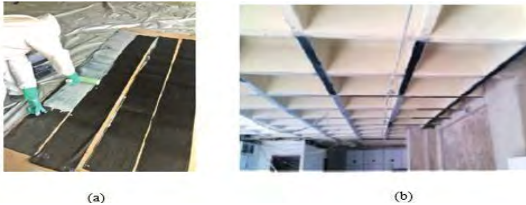
Figura 2.2.. Reforzamiento de viguetas con bandas de CFRP, Sunat Arequipa, adaptada de Sika (2014)- (a) Colocación de resina epóxica, (b) colocado final de bandas de CFRP
