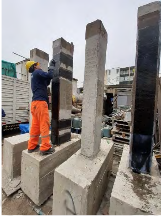
Figura 4.13. Colocación de bandas de fibra de carbono FRP. (Fuente: Propia)
