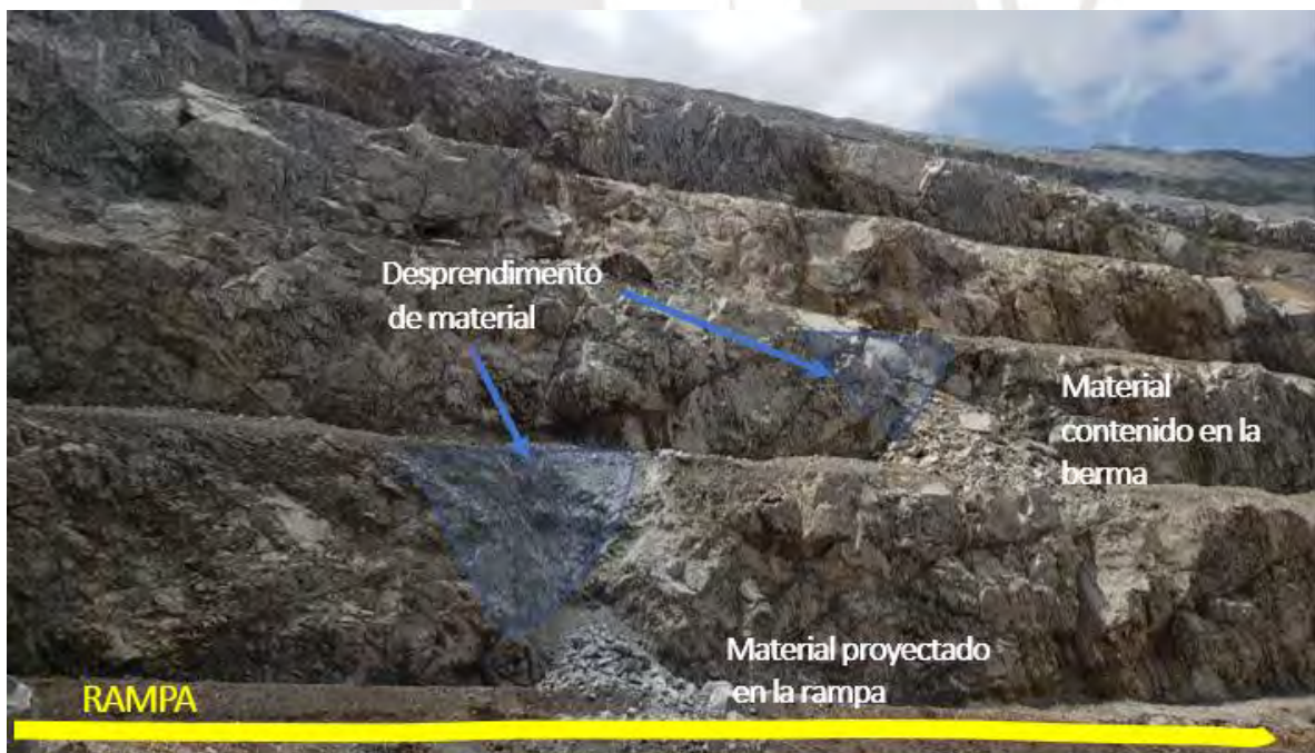
Figura 11.1 Proyección de rocas a nivel de rampa operativa- pared noroeste del tajo.
