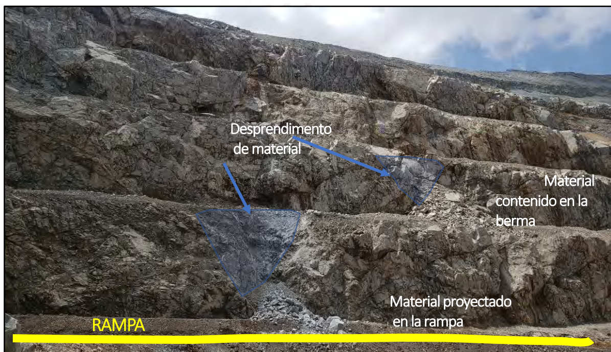
Figura 3.1 Eventos de caídas de roca a nivel de banco- pared noroeste del tajo.
