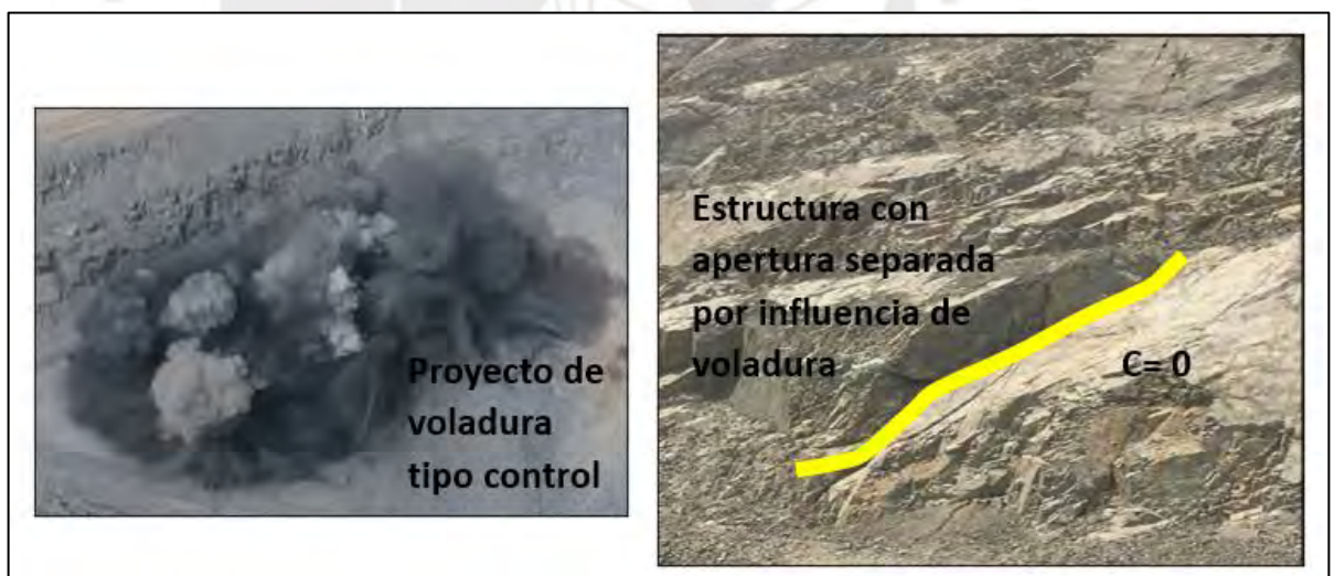
Figura 3.12 voladura y el daño estructural causado.
