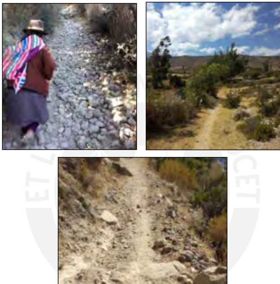
Ilustración 58. A la izquierda superior un camino herradura tipo piedra, al derecha superior un camino tipo hierba y en la parte inferior un camino tipo tierra Foto. Ampuero, 2019
