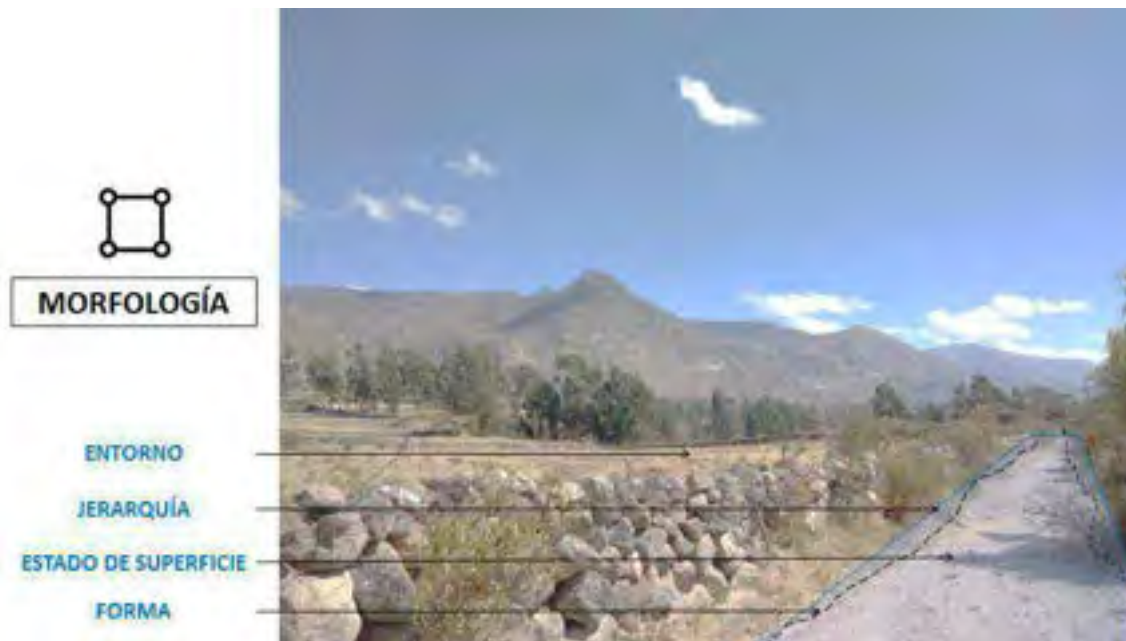
Gráfico 12. Componentes de la morfología de un camino rural Elaboración propia en base a los resultados identificados en los recorridos de campo realizados en el 2019
