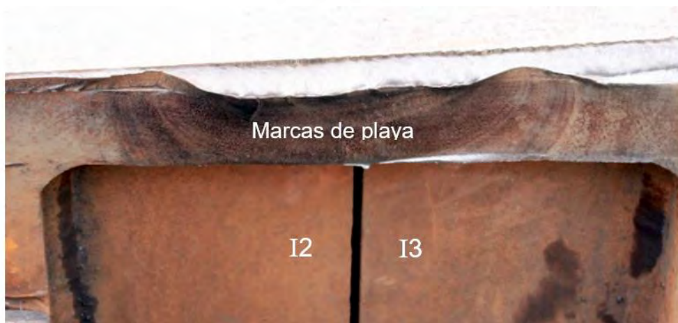
Figura 43. Detalle de la zona fatigada en la región entre los perfiles I2 e I3.
