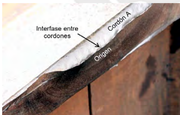
Figura 44. Origen de la fisura por fatiga.
