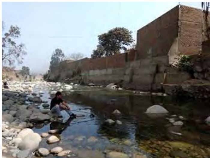
Figura 19. Estación RM-3 puente Los Ángeles
