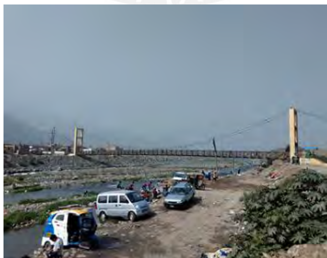
Figura 20. Estación RM-4 puente Los FONCODES
