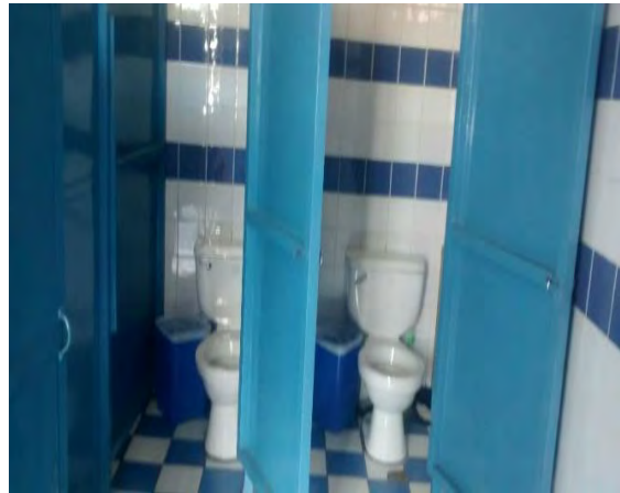
Foto N°:36 Servicios higiénicos administrativos
