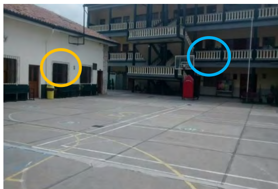
Foto N°: 10 Edificación principal (1er piso) se ubica los ambientes administrativos y Capilla; (2do piso) se ubican las aulas comunes y edificación lateral izquierda (1er piso) se ubica la sala de profesores y el comedor.
