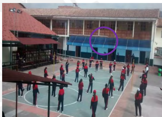
Foto N° 12 Edificación lateral no está en uso (declarada en riesgo por INDECI)
