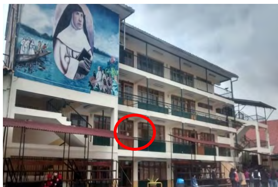
Foto N°:09 Edificación lateral derecha (1er piso) se ubica Coordinación de JEC, tópico, sala de Psicología.
