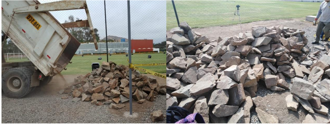
Figura 25. Descarga de las rocas dentro del lugar de trabajo.
