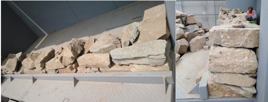
Figura 28. Colocación de piedras en base de muro.
