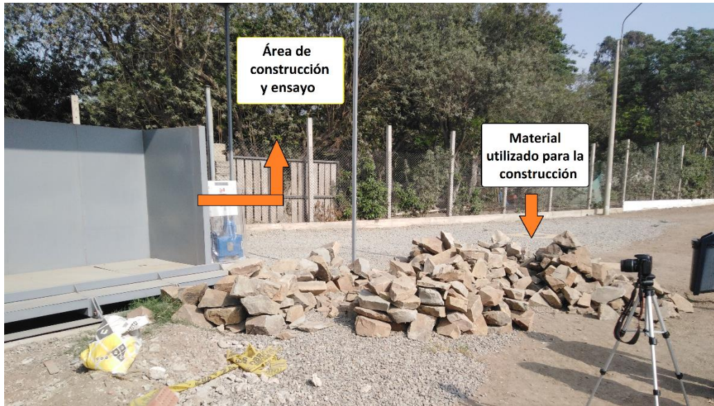
Figura 20. Área de construcción y ensayo.
