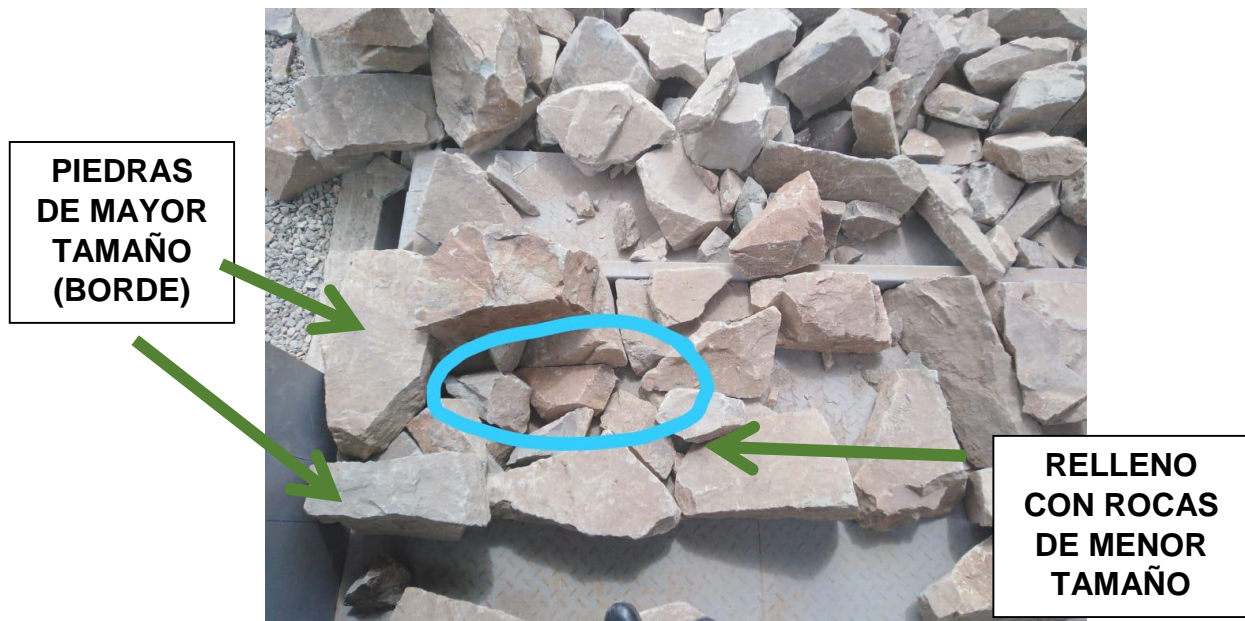
Figura 31. Forma de construcción de las pircas
