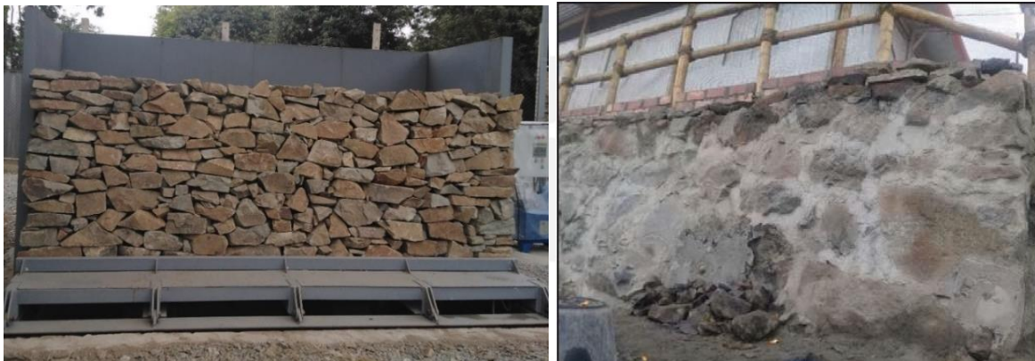
Figura 33. (a) Pirca con junta seca sin acabado, (b) Pirca con acabado de mortero de cemento “pañeteo” Fuente: Rivas (2019)
