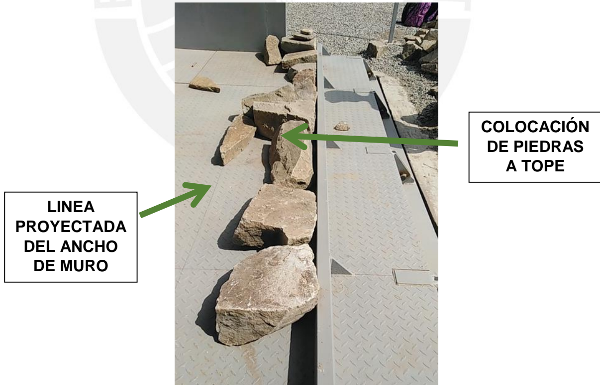
Figura 26. Colocación de piedras en la base
