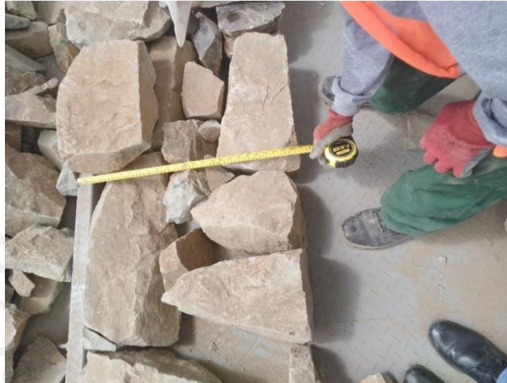
Figura 27. Verificación de ancho de muro
