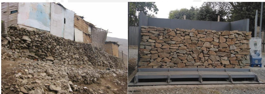
(a) (b) Figura 68. (a) Pirca con piedras redondeadas (b) Pirca con piedras angulosas
