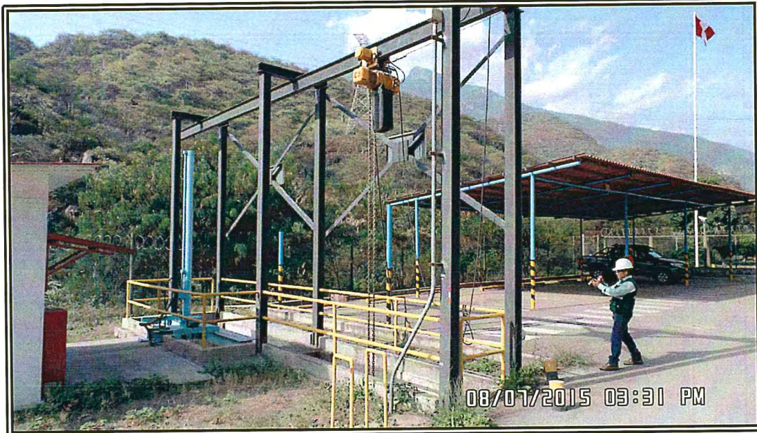
Fotografía 3. Supervisor cerca al punto de descarga de aguas turbinadas de la C.H. Carhuaquero IV.
