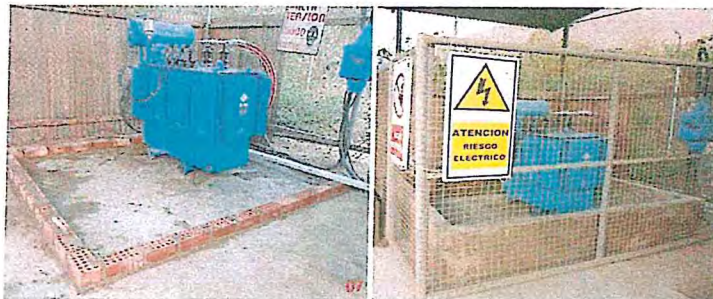
Foto 1. Completando el Sistema de Contención. Foto 2. Sistema de contención completo
