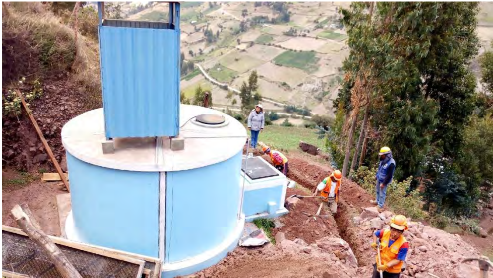
Foto 5.4: Sistema de cloración del agua por goteo
