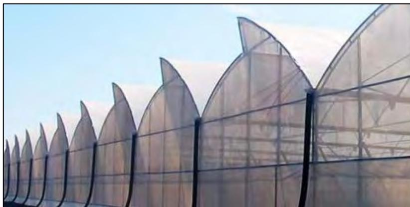
*Figura 4* Invernadero tipo asimétrico
