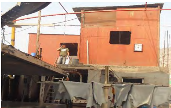
Figura 11. Instalaciones de Curtiembre Fénix SRL. Tomado de “Proyecto INNOVATE PERÚ”, por Citeccal Lima, 2012.
