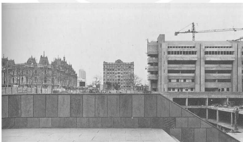
Fig. 2 Construcción del Centro Cívico de Lima
