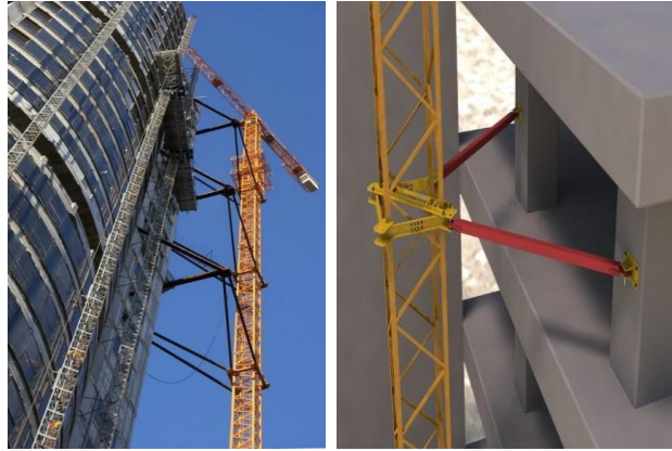
Fig. 12 Arriostre del mástil.
