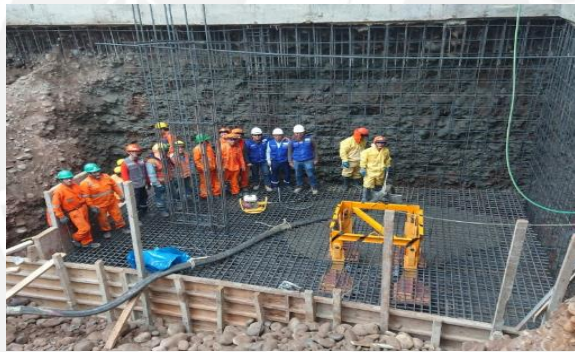
Fig. 8 Base empotrada en zapata
