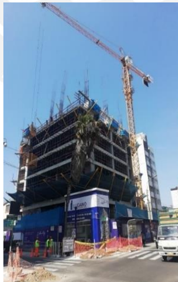
Fig. 13 Pluma horizontal en edificio Liberty de Lugano S.A.C
