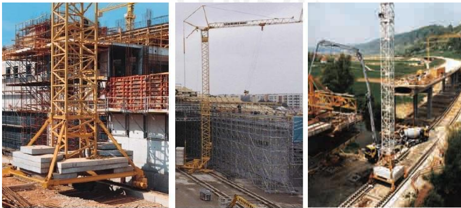
Fig. 9 Torre grúa de traslación horizontal
