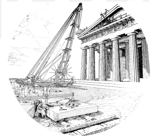
Fig. 1 Torre grúa con sistemas de poleas durante la construcción de un templo griego
