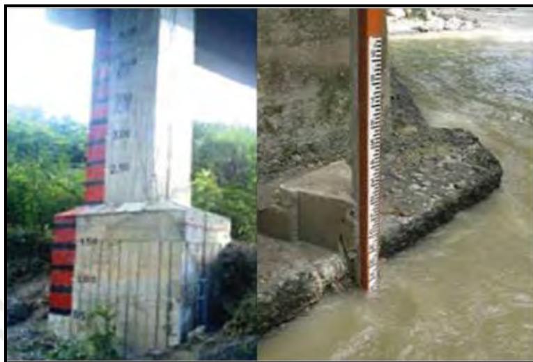
FIGURA 54: Limnímetro ubicado en un Puente y Muro de Concreto
