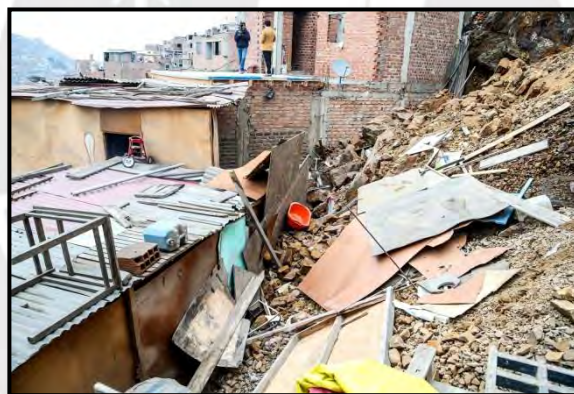
Figura 22: Derrumbe en Asentamiento Humano del Agustino
