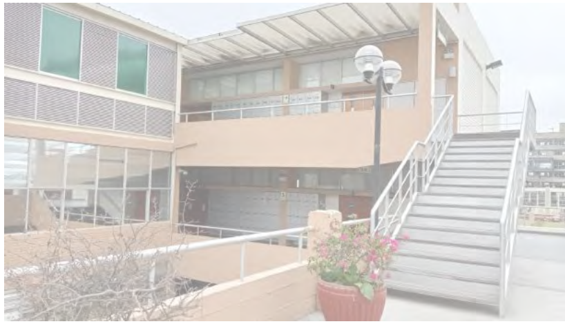
Figura 23. Escalones Previos EEGCC
