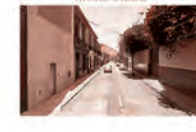
5 ESTACIONAMIENTO Y MURO CIEGO
