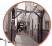
Quintas y Callejones. En estado de deterioro, actualmente son tugurios que crecen sin control.
