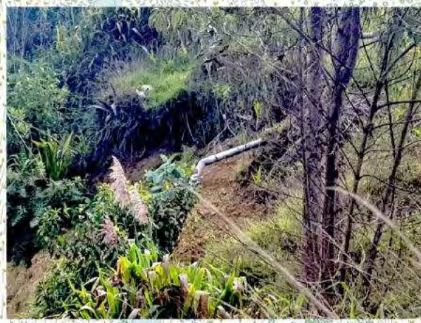
Tubería de desemboque de aguas grises domiciliarias
