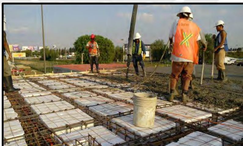
Figura 04. Vaciado de concreto en techo. Fuente: Habitissimo.
