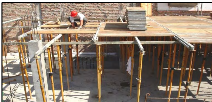
Figura 03. Instalación de encofrado de techo. Fuente: Línea Prevención.
