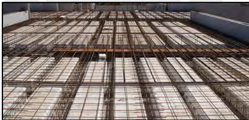
Figura 02. Instalación de aceros en techo. Fuente: Optimiza contratistas.
