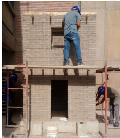
Figura 5.10. Retiro y quemado de las puntas de las cuerdas exteriores e interiores de los muros.
