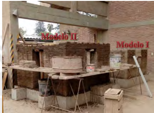
Figura 4.11 Altura completa de muros del primer nivel
