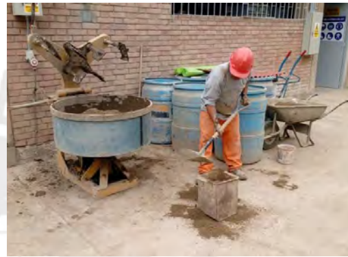
Figura 4.5 Control de relación tierra-arena mediante recipientes de lata.
