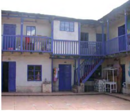
Figura 2.6 Configuración de vivienda de adobe, forma C (Ruiz, 2013)
