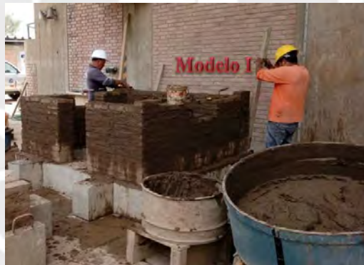
Figura 4.9 Empleo de reglas de madera y cordel para el asentado de unidades de adobe
