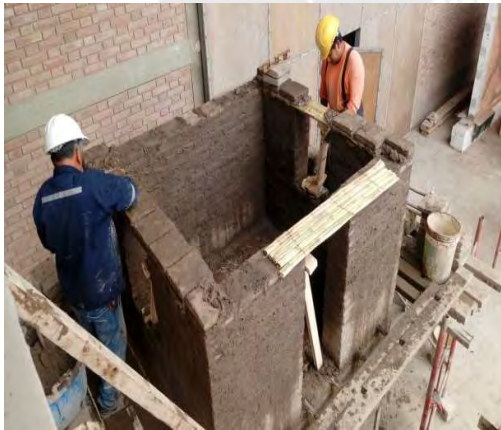
Figura 4.14 Instalación de caña carrizo en dintel
