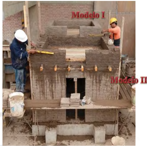
Figura 4.13 Asentado unidades de adobe correspondiente al segundo nivel.
