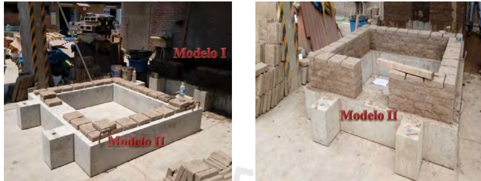
Figura 4.8 Emplantillado y asentado de unidades de adobe.
