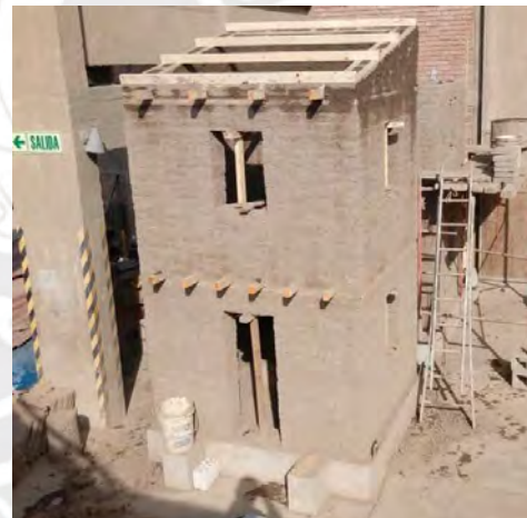
Figura 4.18 Construcción del modelo finalizada
