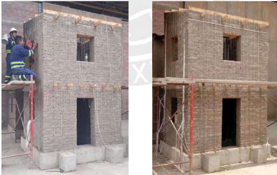
Figura 5.7 Instalación de cuerdas verticales en el primer y segundo nivel.
