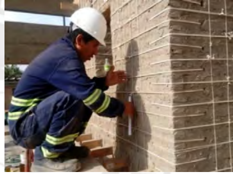
Figura 5.10. Retiro y quemado de las puntas de las cuerdas exteriores e interiores de los muros.
