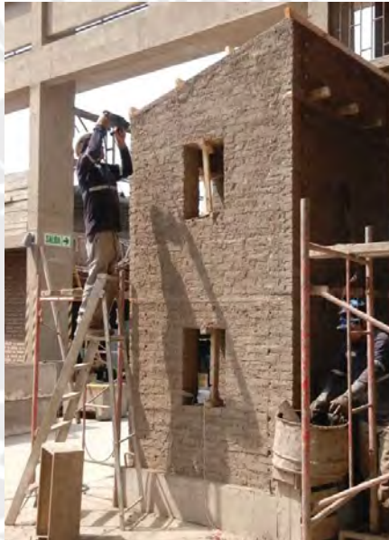
Figura 5.5 Perforación de puntos para la continuidad de las cuerdas.
