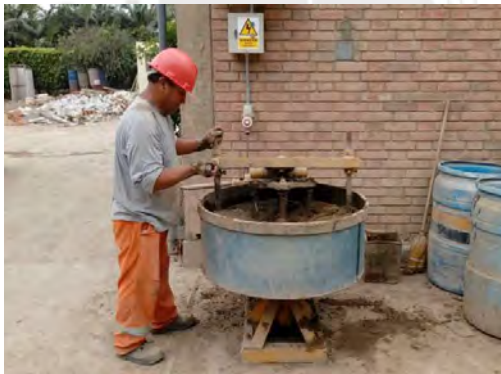
Figura 4.6 Preparación del mortero 1:1, empleando una mezcladora mecánica.
