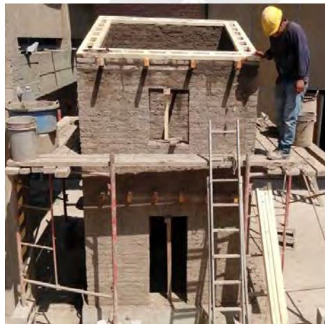
Figura 4.17 Instalación de viga diafragma y viguetas de madera
