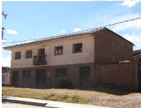
Figura 2.5 Configuración de vivienda de adobe, forma L (Blondet, 2004)
