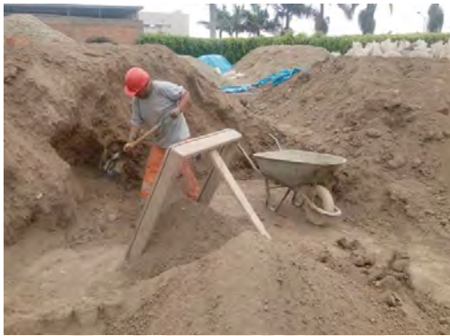
Figura 4.4 Selección de tierra mediante zarandas
