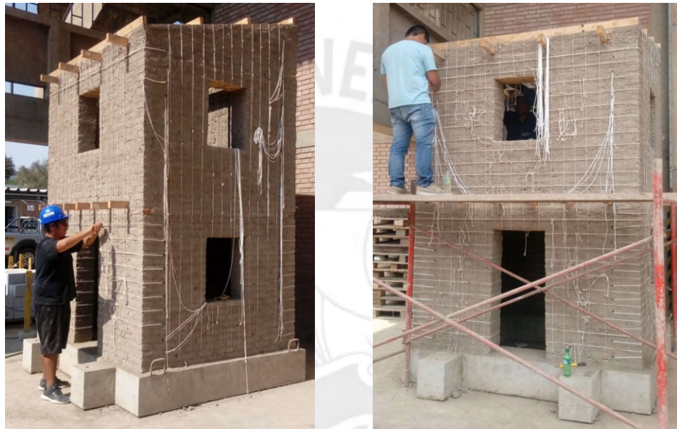
Figura 5.8 Instalación de cuerdas horizontales en primer y segundo nivel.
