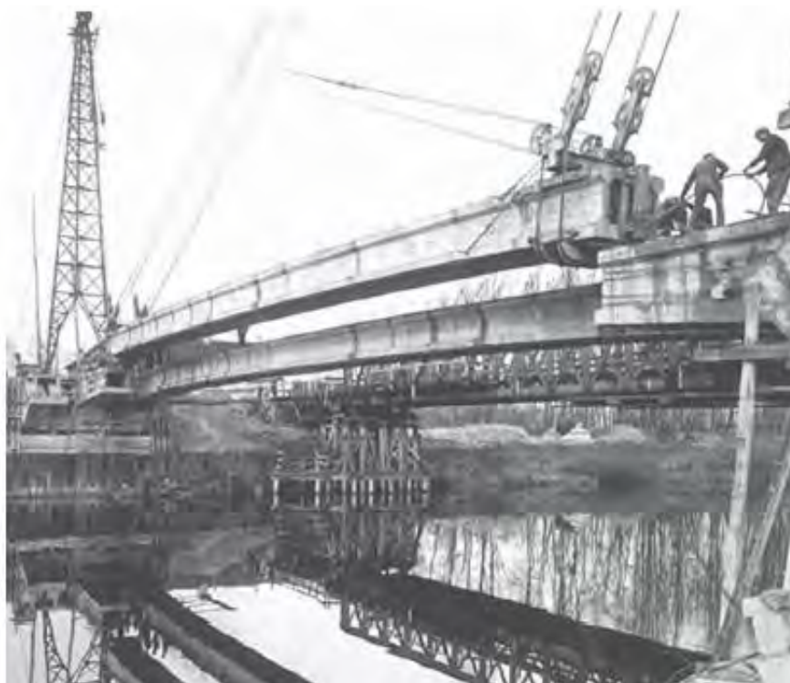
Figura 1-1 Puente Pontes de Fer (Noticreto, 2015)
