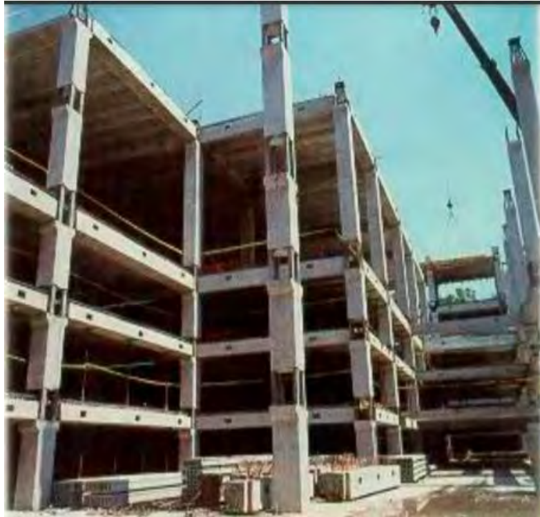
Figura 3-18 Conexión tipo ventana (Construaprende, 2018)
